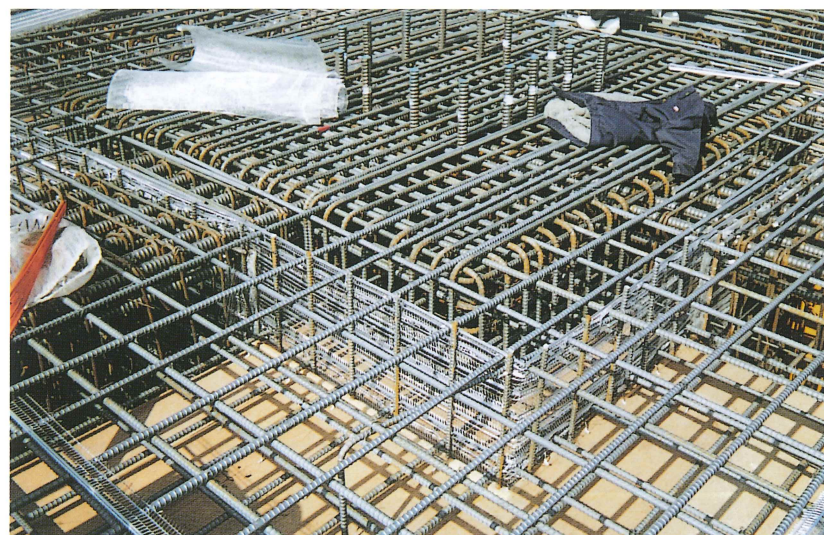
高強度コンクリート打継
